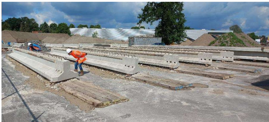
Figuur 6 Kwaliteit van de geogste liggers is vaak nog heel goed
