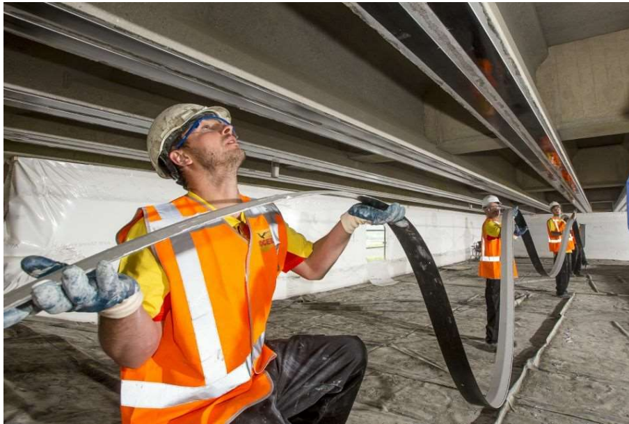
Figuur 2 Lijmwapening bij de Nijkerkerbrug
